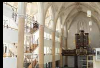
▼ In de zijbeuk is een geheel autonome constructie van drie verdiepingen gebouwd.
