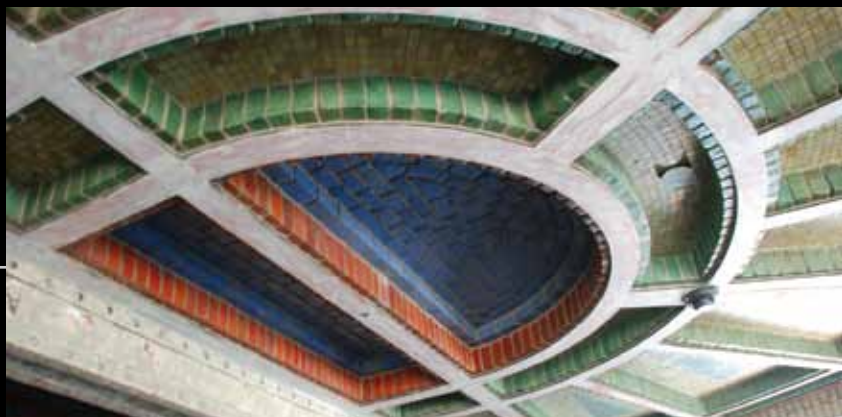
▲ Eerst zijn alle oude alkydverflagen verwijderd.
